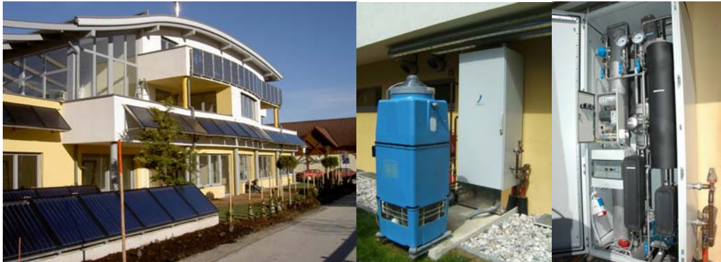
Abb. 4 – Solarkollektoren an Fassade und Boden sowie Absorptionskältemaschine chillii® PSC10 des Trainingscenter und Bürogebäudes BachlerAustria (Quellen: SolarNext)
