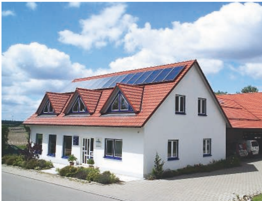
Citrin Solar hat bisher sechs solare Kühlanlagen realisiert.
